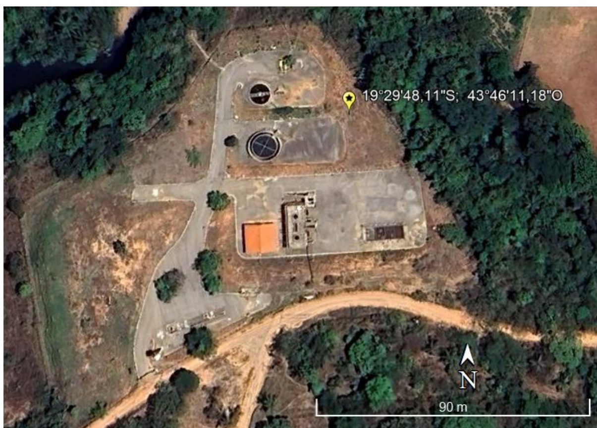
Figura 80 – Estação de Tratamento de Efluentes (ETE) Jaboticatubas. Elaborado por: Dfan Urbanismo.
