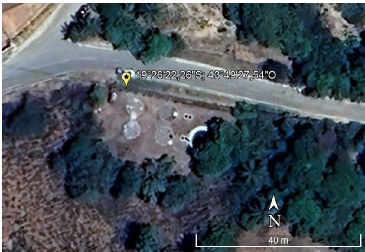
Figura 81 – Estação de Tratamento de Efluentes de São José de Almeida.
